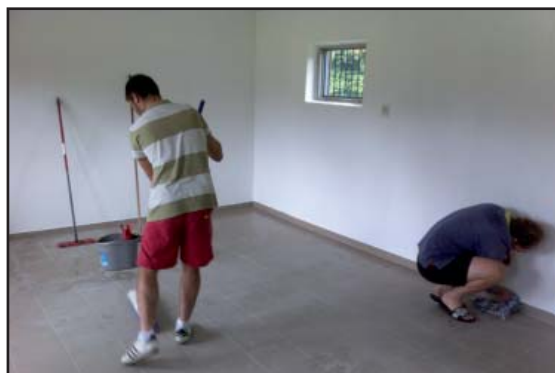
Úklid zrekonstruovaných kabin
