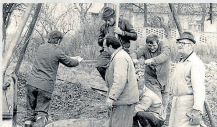
DO PRÁCE. Budování studny pro školu u transformátoru v roce 1979.
