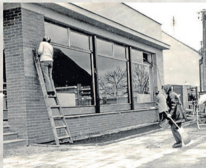
PŘED NOVÝM OBCHODEM. Konečné úpravy místních na obchodním domě v roce 1976.
